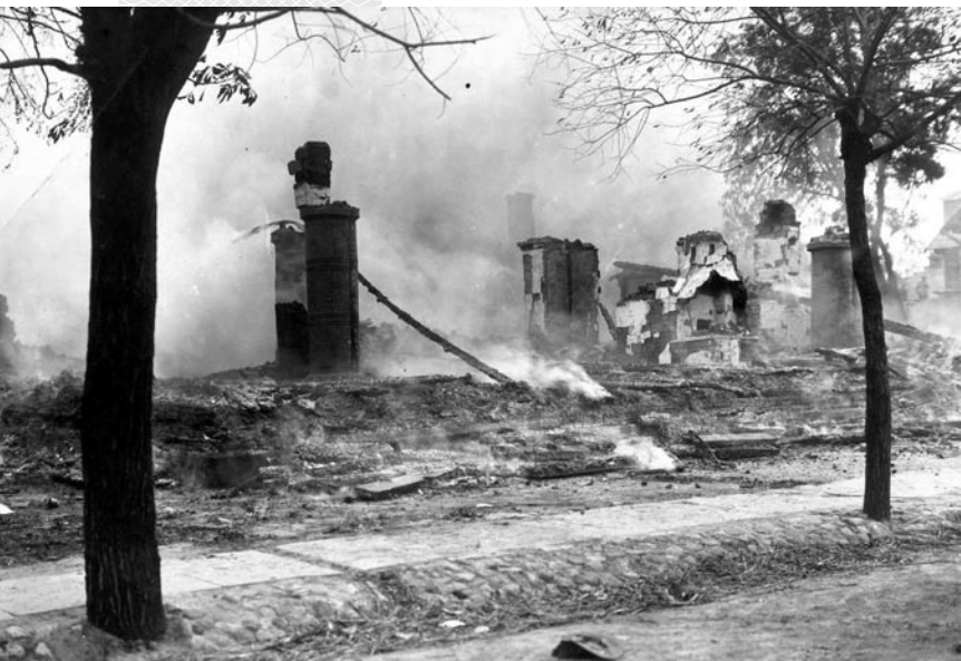
▼ Разрушенная крепость в Брест-Литовске. 1915 год
