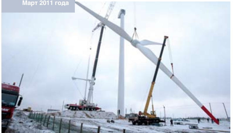
Монтаж лопастей ветроустановки. Март 2011 года
