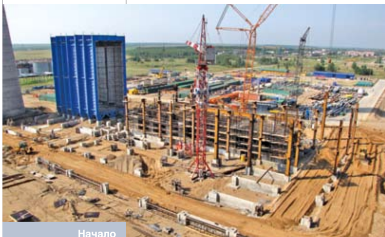
Начало строительства нового энергоблока на Минской ТЭЦ-5. Весна 2010 года
