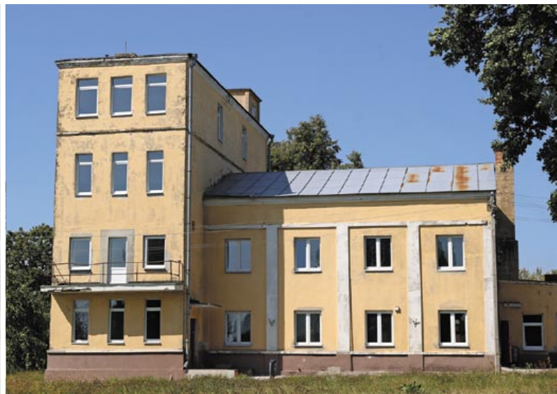
В Негорелом сохранилось здание электростанции 1920-х годов, работала она на дровах
