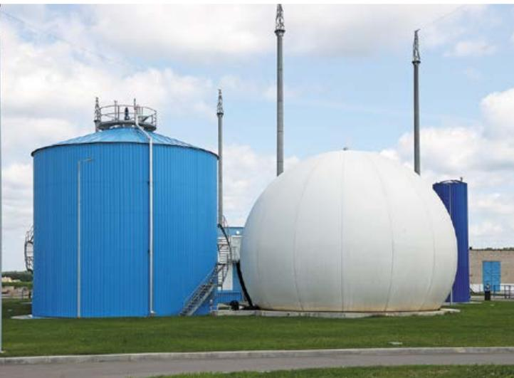
На биогазовом комплексе Слонимского водоканала из сточных вод получают электрическую и тепловую энергию. Этот процесс полностью автоматизирован
