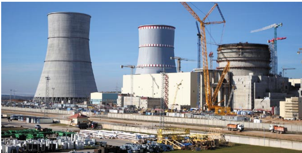
◀ Строительство БелАЭС. Октябрь 2018 года
