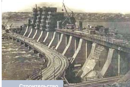
Строительство ДнепроГЭС. 1934 год
