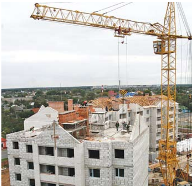
Строительство 80-квартирного жилого дома в Речице ведется по современной энергосберегающей технологии
