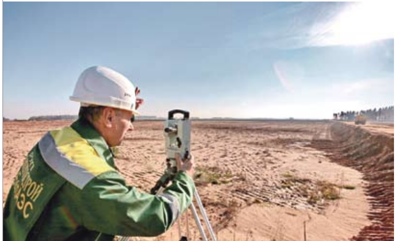
Геодезисты на месте строительства первого энергоблока белорусской АЭС
