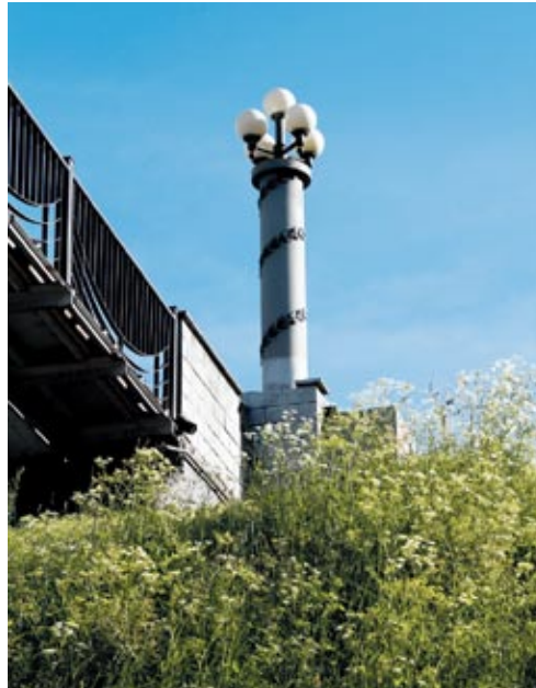
◀ Мост в Новополоцке
