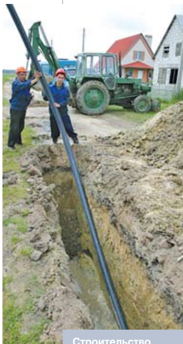
Строительство водопровода в деревне Залесье Кобринского района
