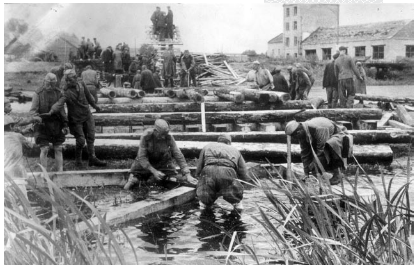
▼ Строительство моста через Днестр
