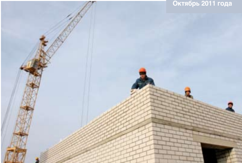
Строительство нового общежития БГСХА. Октябрь 2011 года
