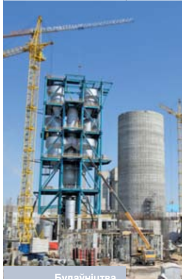
Будаўніцтва новай тэхналагічнай лініі ў ААТ «Крассельскбудматэрыялы». Чэрвень 2011 года
