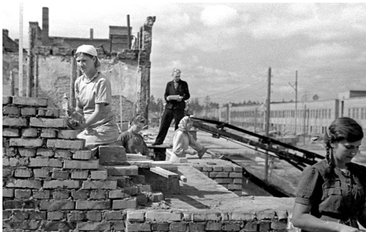
Строительство Минского тракторного завода. 1947 год
