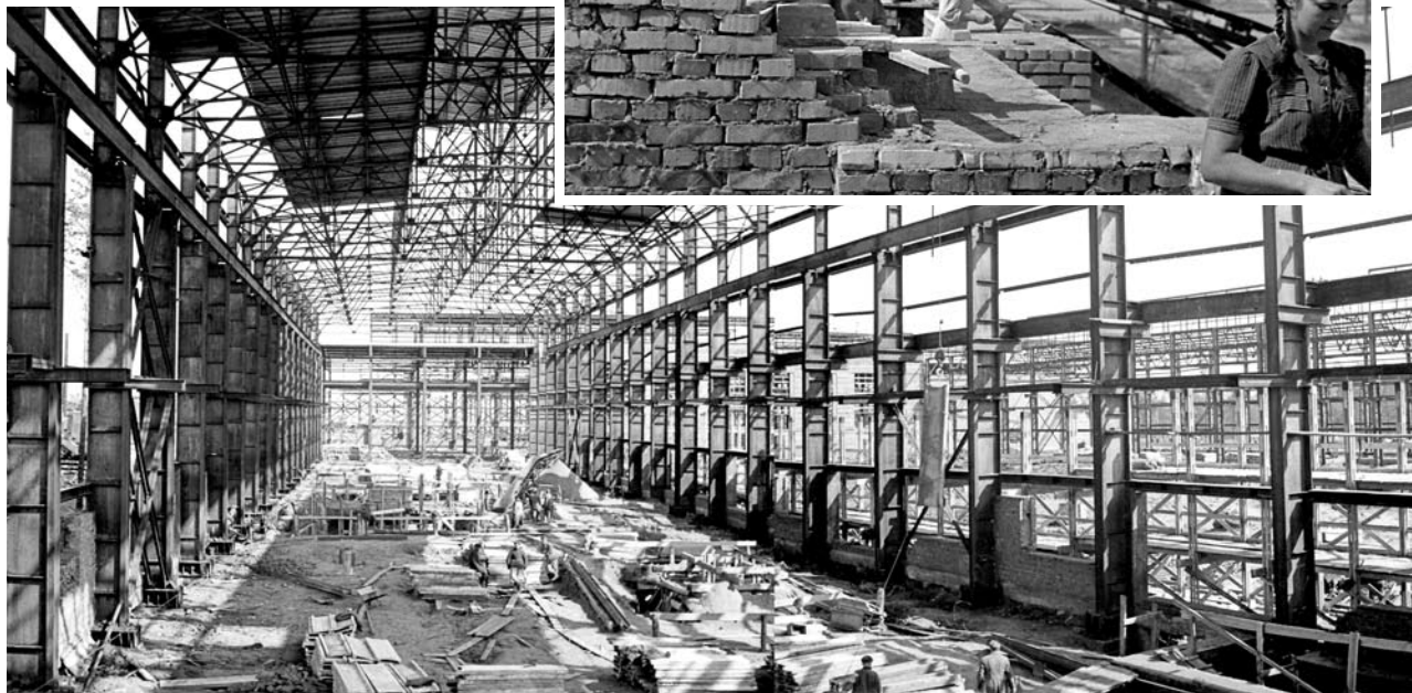
Строительство кузнечного цеха Минского тракторного завода. 1948 год
