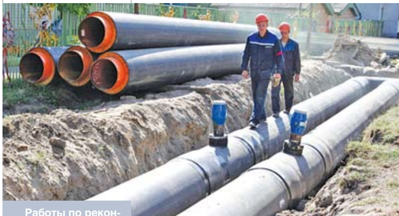
Работы по реконструкции тепловых сетей в Бресте
