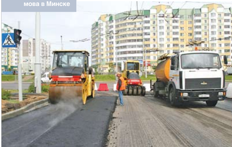
Капитальный ремонт участка проспекта Любимова в Минске
