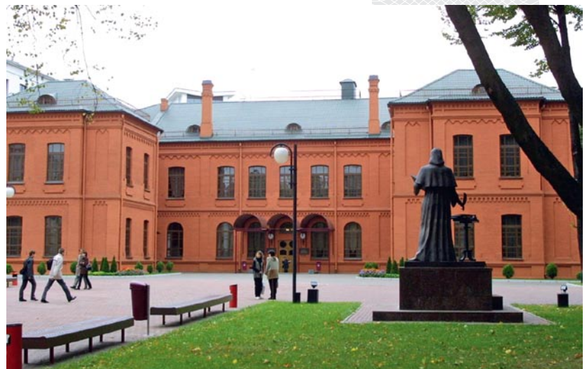
▼ Здание ректората БГУ
