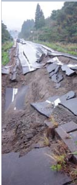
Последствия землетрясения в Японии 11 марта 2011 года
