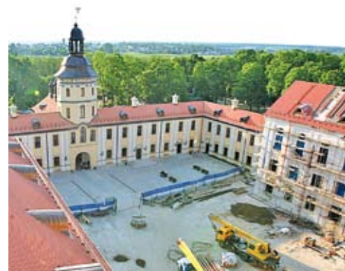
Реставрационные работы в Несвижском замке
