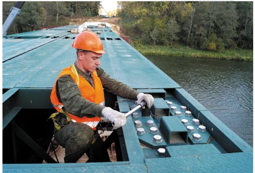
▲ Командир отделения младший сержант Артем Гопша соединяет пролетные строения
