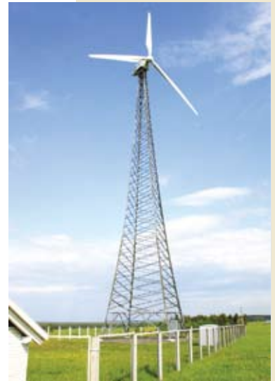
Ветряная энергетическая установка в Мядельском районе
