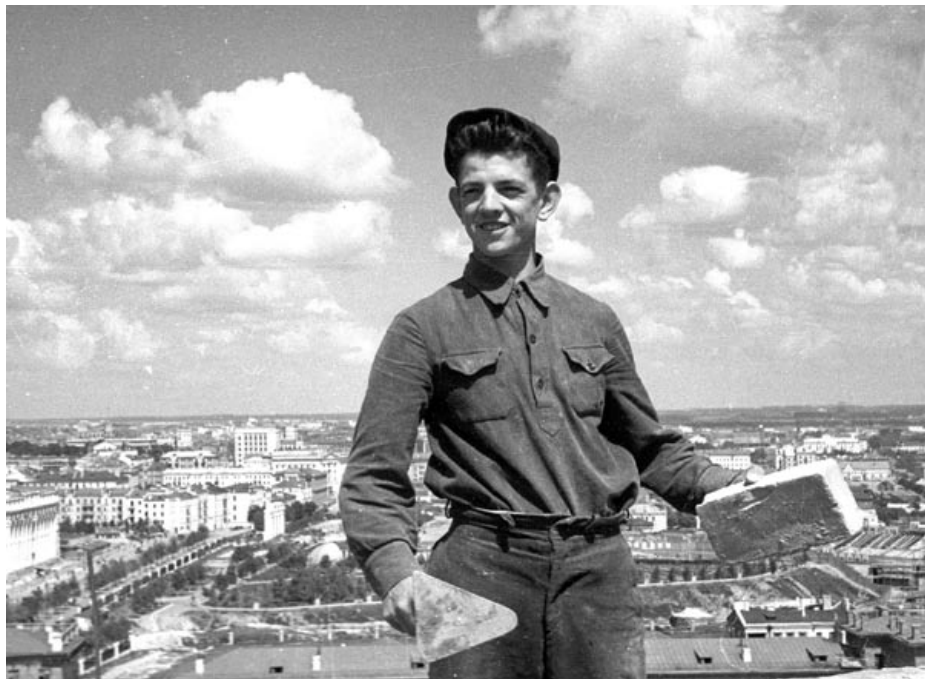
На будаўніцтве Прывакзальнай плошчы ў Мінску. 1952 год
