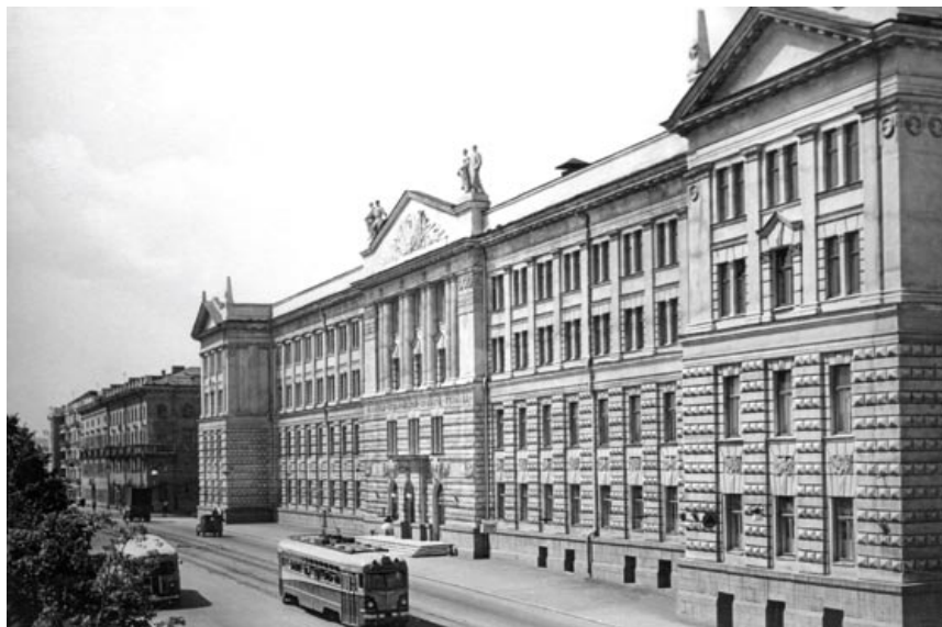
Здание Минского СВУ. Вид с ул. М. Горького. Конец 1950-х годов
